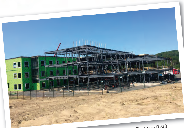
Chantier du CHSLD
