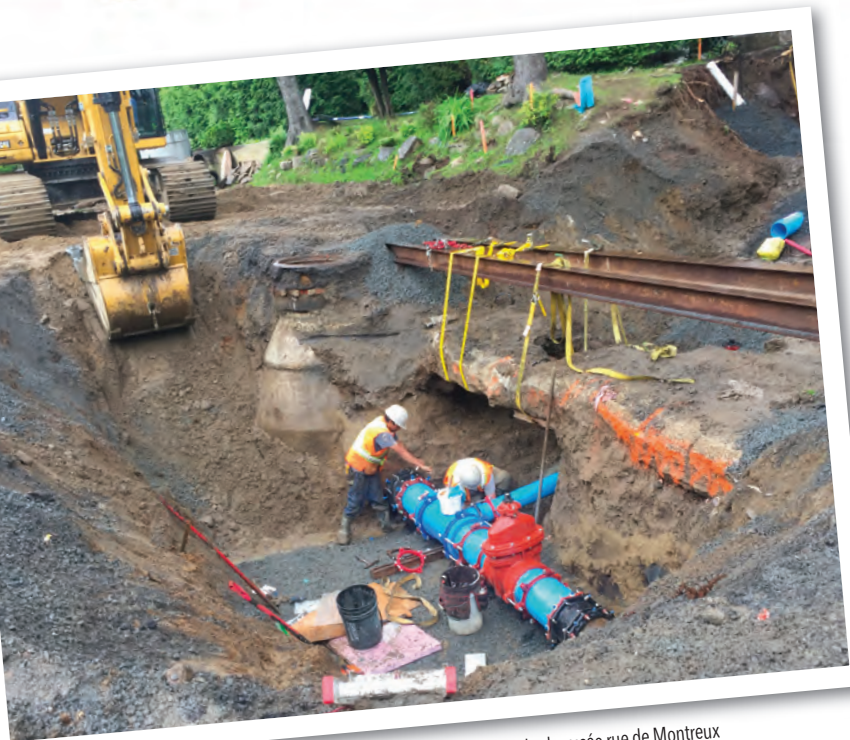
Réfection des conduites d'aqueduc, d'égout et de la chaussée rue de Montreux
