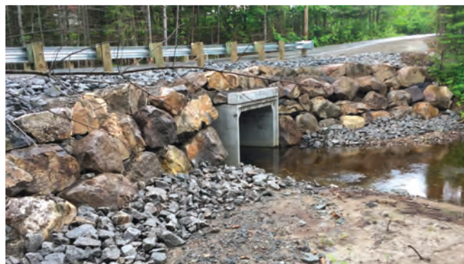
Réfection pontceau rue du Manège
