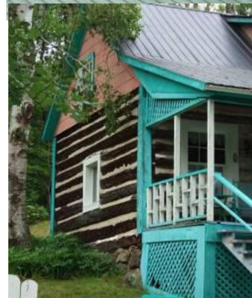
Photos : 1) Maison coloniale, Sainte-Adèle. 2) Détail : assemblage de la structure en queue d'aronde. 3) Détail : Toit recouvert de tôle à grange. 4) Détail : mur latéral.
