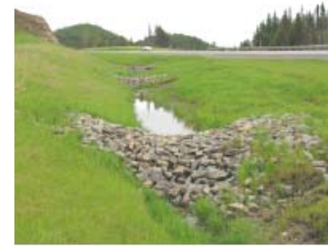
Bernes en escalier - Source : MTQ, Estrie
