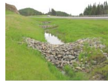
Bernes en escalier - Source : MTQ, Estrie
